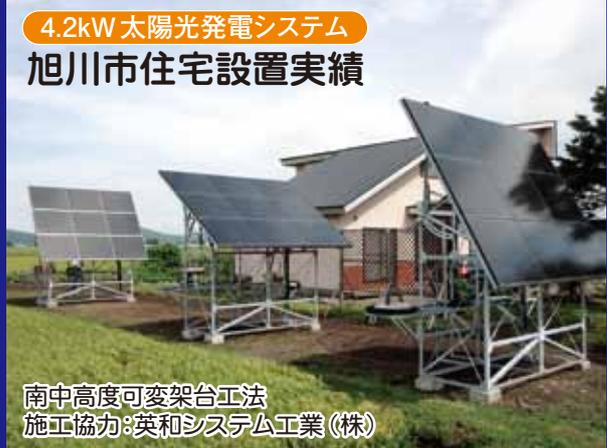
南中高度可変架台工法
