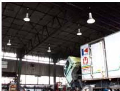
丁寧な対応が好評の同社。実績のある熟練した整備士が点検・整備・検査を行う国土交通省指定の民間車検場。工場内の水銀灯をLED照明に交換し広々とした空間を明るく作業しやすい環境へ。消費電力の削減も実現。
